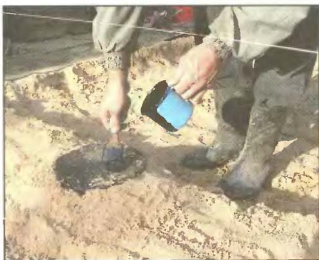
Гидроизоляция торца опоры битумной мастикой
