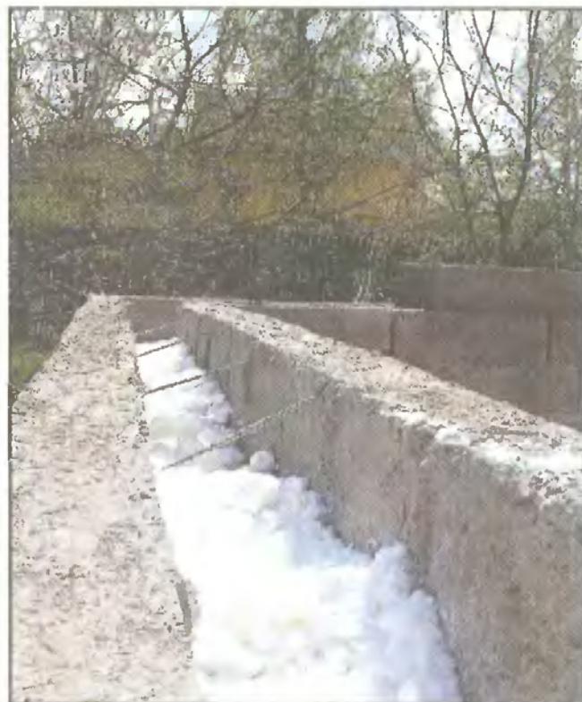
Заполнение полости трехслойной стены утеплителем
