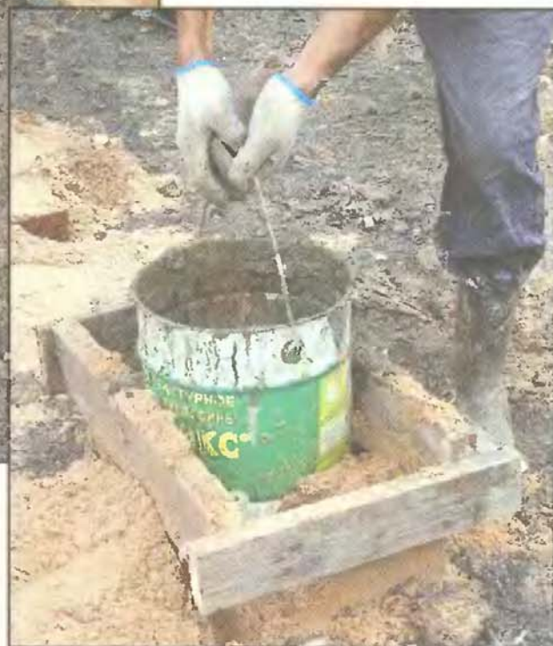
Подъем приспособления после бетонирования
