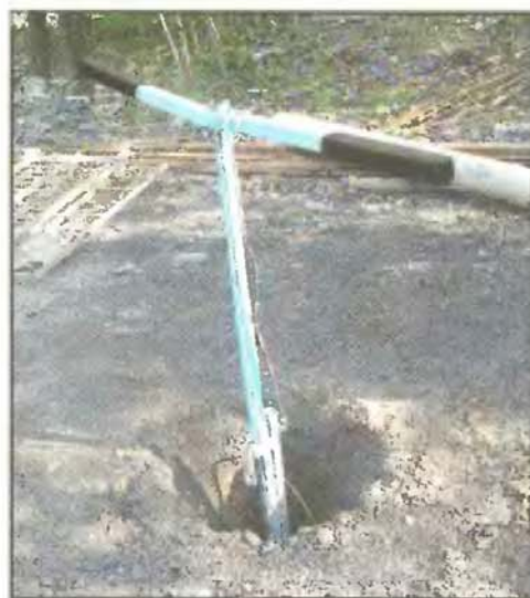
Бурение скважины
