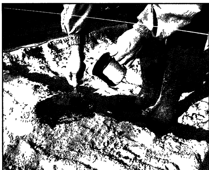
Гидроизоляция торца опоры битумной мастикой
