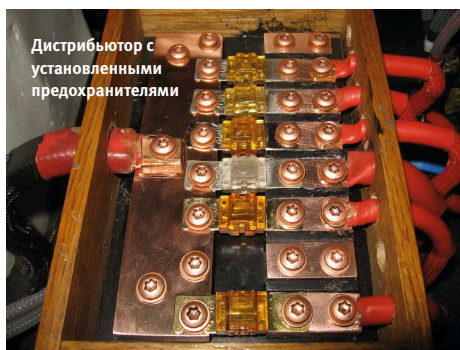
Места соединений залиты воском (кантри-стиль)
