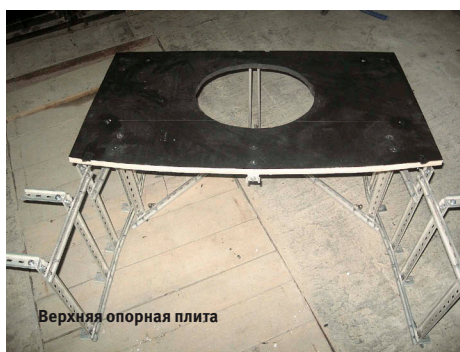
Крепление плиты к ферме
